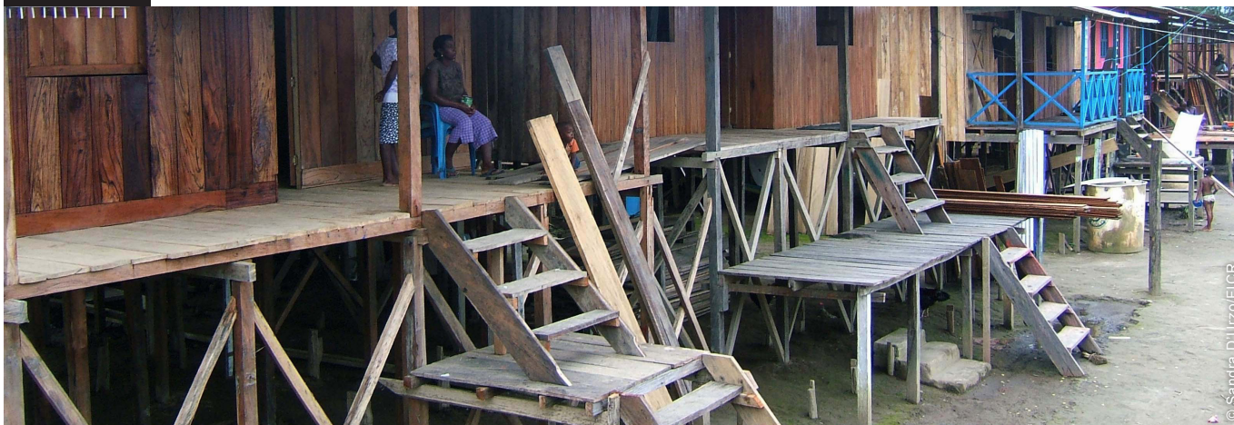
En una aldea "modelo", la organización construyó 80 casas elevadas e infraestructura comunitaria.
