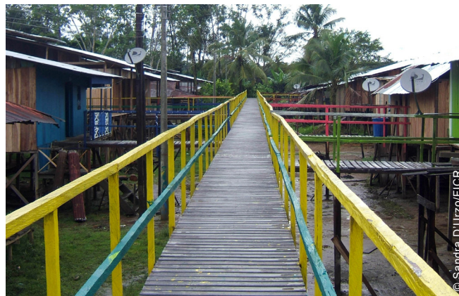
Se construyeron pasarelas elevadas para que la comunidad se mantuviera conectada cuando llegaran las próximas inundaciones.
